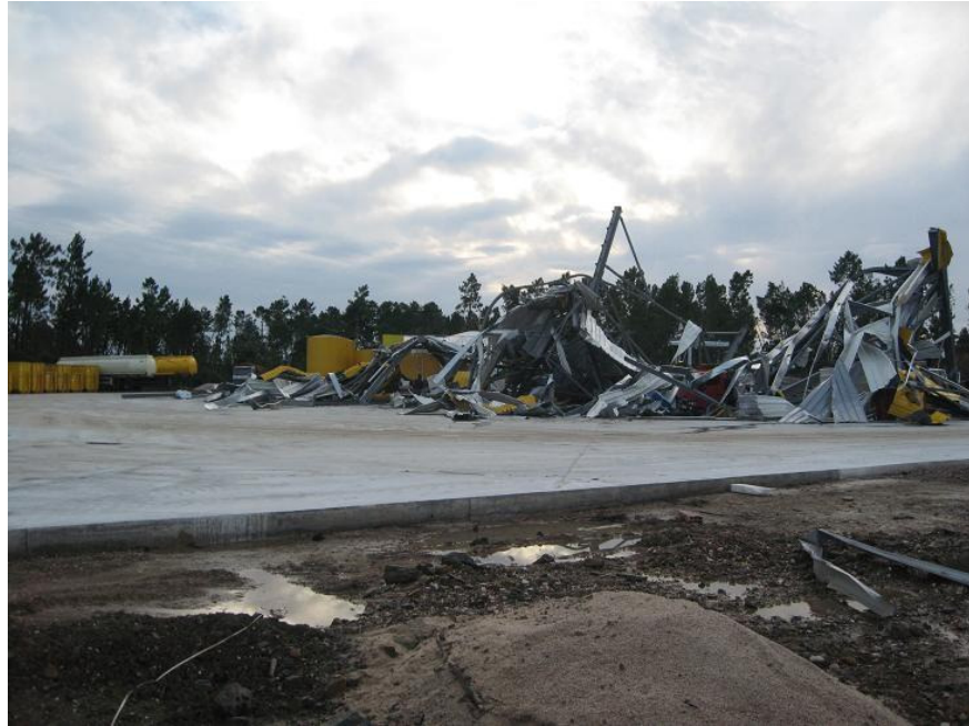
Figura 1- Destruição completa de uma estrutura industrial (edifício metálico), localizada na zona industrial da Sertã, referenciada com o ponto "Sertã", no trajecto de destruição do tornado de Tomar na figura 10
