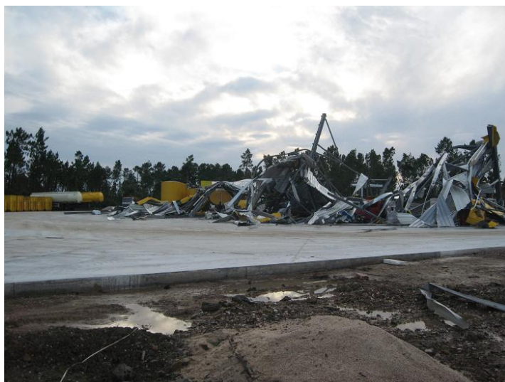
Figura 9 - Destruição completa de uma estrutura industrial (edifício metálico), localizada na zona industrial da Sertã,
