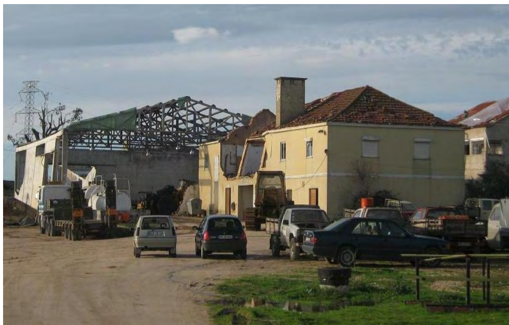
Fig F – Detalhe de colapso total de paredes de estrutura fabril (em 2º plano) e de colapso total do telhado e de paredes do piso superior em casa de habitação (1º plano), Venda Nova .
