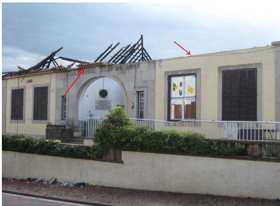
Fig C – Colapso total do telhado do Jardim Escola S. João de Deus, Tomar. A própria estrutura de suporte (ver setas) foi arrancada (seta à direita).
