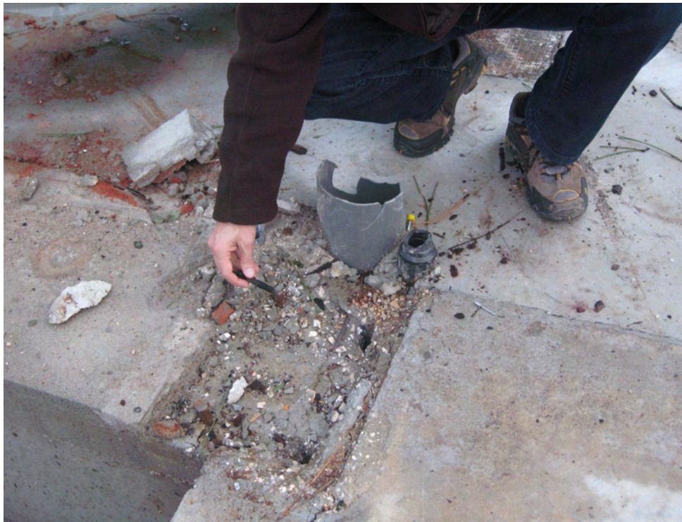
Fig M – Pormenor da secção de uma viga de betão, cortada pela carga do esforço a que toda a estrutura esteve submetida, correspondente à Fig J.
