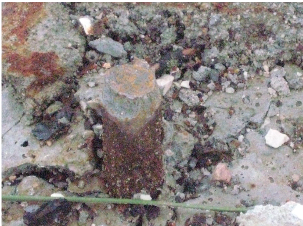
Fig N – Detalhe da secção de uma viga de betão, sendo visível o corte de um dos 4 ferros que fazia parte da armação do betão, local referido na Fig J.
