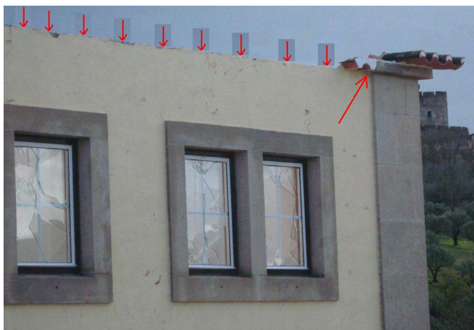
Fig D – Pormenor do colapso da estrutura de suporte do telhado referido na fig C: a seta maior assinala uma pequena zona que se manteve como originalmente; as restantes evidenciam parte da zona em que a estrutura foi, literalmente, arrancada.
