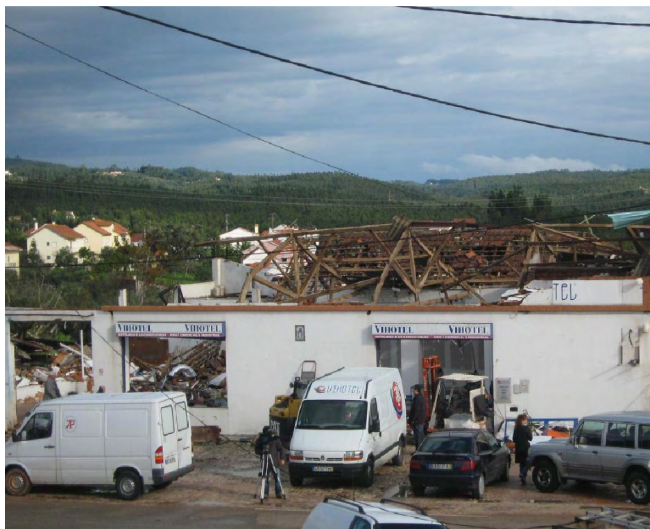
Fig G – Destruição quase total de edifício em alvenaria. Visível desaparecimento do telhado e grande parte da estrutura de suporte, bem como colapso total de algumas paredes, Venda Nova.
