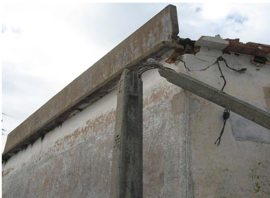
Fig H – Poste de média tensão partido (um de muitos exemplos do mesmo tipo), Venda Nova.
