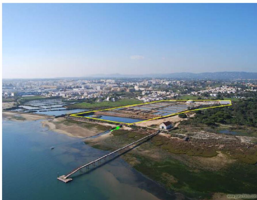
Figura 1 – Fotografia aérea das instalações da Estação Piloto de Piscicultura de Olhão (delimitada a amarelo) e sua localização geográfica. Captação da água assinalada com a seta verde.
