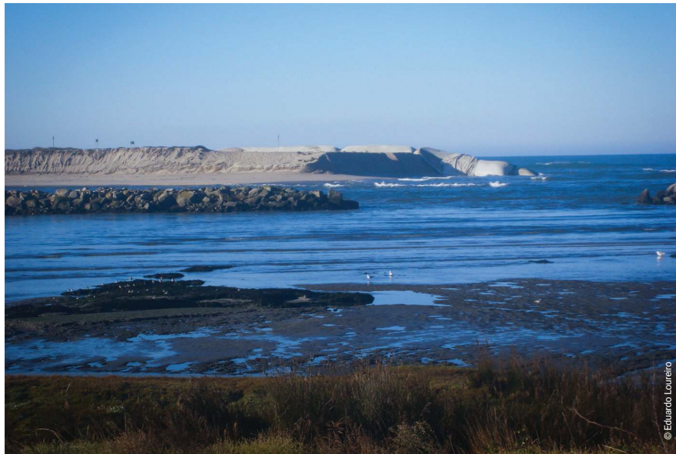
Ruptura da restinga de Ofir após um galgamento marinho, em janeiro de 2019. Pormenor, no qual se podem observar os geotêxteis instalados anteriormente.
