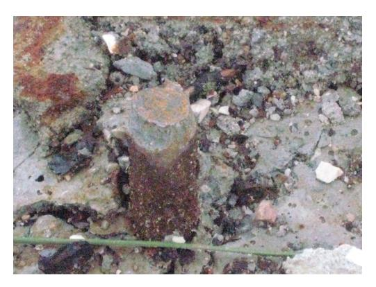
Fig N – Detalhe da secção de uma viga de betão, sendo visível o corte de um dos 4 ferros que fazia parte da armação do betão, local referido na Fig J.
