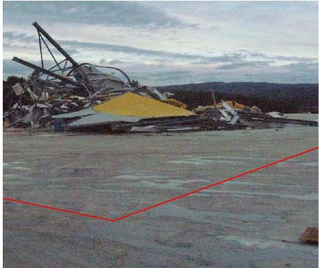
Fig J – Estrutura fabril (edifício metálico) completamente destruída, estando marcado a segmento vermelho o recorte aproximadamente correspondente à localização original das paredes. Sertã, zona industrial.
