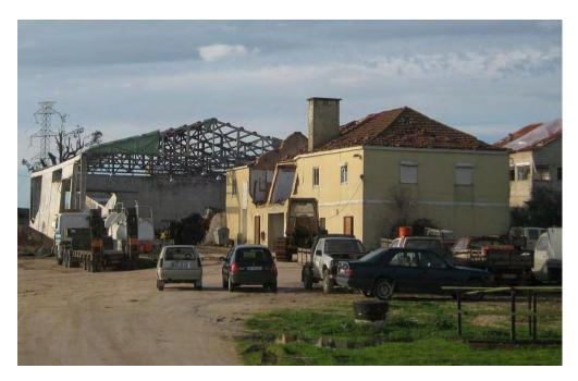
Fig F – Detalhe de colapso total de paredes de estrutura fabril (em  $2^{\circ}$  plano) e de colapso total do telhado e de paredes do piso superior em casa de habitação ( $1^{\circ}$  plano), Venda Nova .
