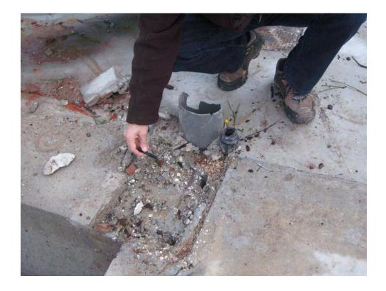
$\label{eq:figm} Fig\ M-Pormenor\ da\ secção\ de\ uma\ viga\ de\ betão,\ cortada\ pela\ carga\ do\ esforço\ a\ que toda\ a\ estrutura\ esteve\ submetida,\ correspondente\ à\ Fig\ J.$
